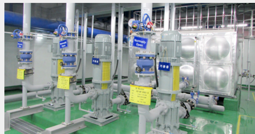
冷却塔排水再利用系统
